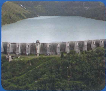
Barrage de la Girotte.
